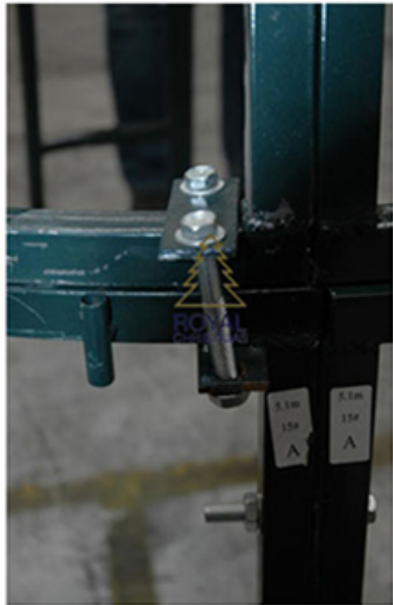
8. Steek de bout door het gat en draai de moer vast.
